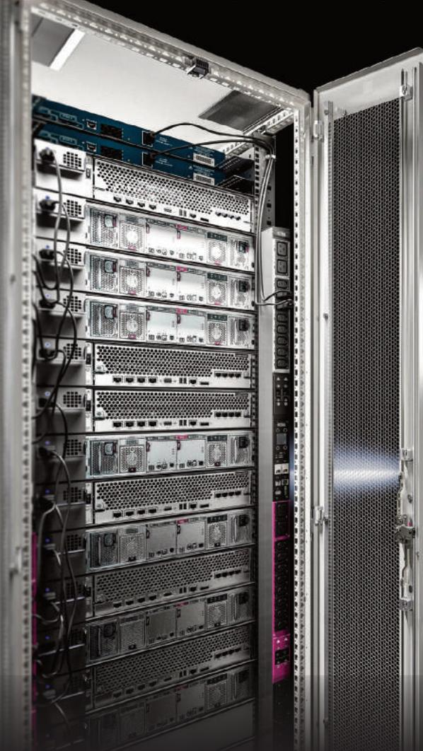
**Bild 2** | Durch die kompakte und schmale Bauform lassen sich PDUs im Raum zwischen Seitenwand und 19"-Montagerahmen montieren.
