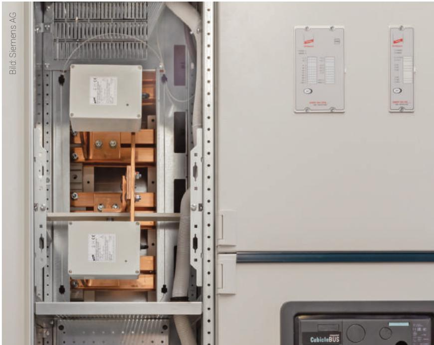
**Bild 3** | Der modulare Aufbau des Störlichtbogen-Schutzsystems Dehnshort ermöglicht eine individuelle und flexible Auslegung und lässt sich daher sehr einfach erweitern.
