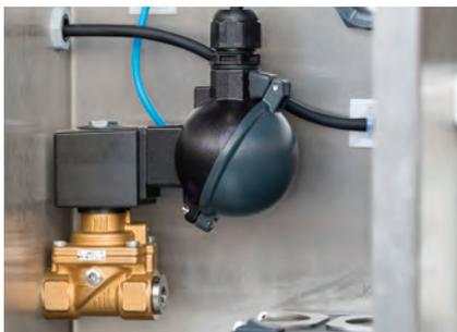
Bild 2 | Im Normalbetrieb stromlose Magnetventile mit mechanisch einstellbarer Durchflussmenge bieten einen absolut sicheren und ausfall-
