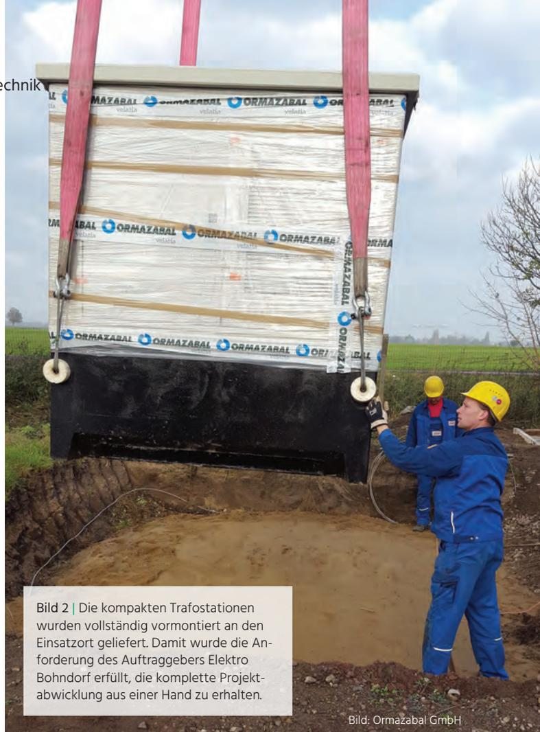
Bild 2 | Die kompakten Trafostationen wurden vollständig vormontiert an den Einsatzort geliefert. Damit wurde die Anforderung des Auftraggebers Elektro Bohndorf erfüllt, die komplette Projekt- abwicklung aus einer Hand zu erhalten.
