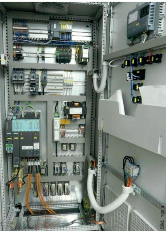
Bild 3 | Aufgeräumter Anblick: Alle Schaltschränke werden mit Eplan Pro Panel geplant.
