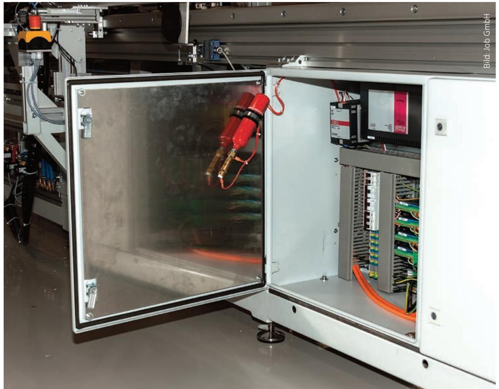
Bild 3 | Geräteintegrierter Brandschutz mit automatischen Miniatur-Feuerlöscheinheiten ergänzt die traditionellen Brandschutzkonzepte und kann helfen, elektrische Geräte und Anlagen noch sicherer zu machen.
