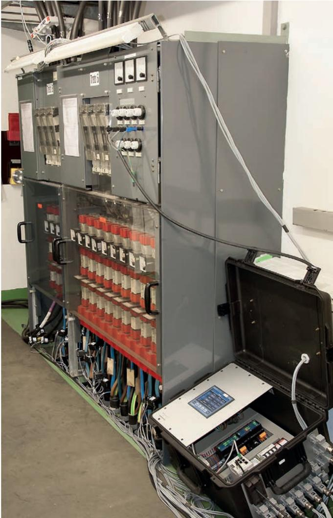
**Bild 2 |** Die mobile Messbox neben einem Abgangsfeld. Die Klappwandler lassen sich ohne Eingriff am Leiteranschluss montieren und demontieren. Das macht den mobilen Einsatz erst möglich.
