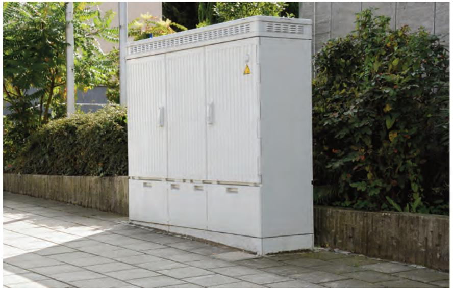
Bild 3 | Multifunktionsgehäuse bzw. Kabelverzweiger haben unter anderem die Funktion, Telefon, Internet und TV-Signale in die Häuser zu bringen.
