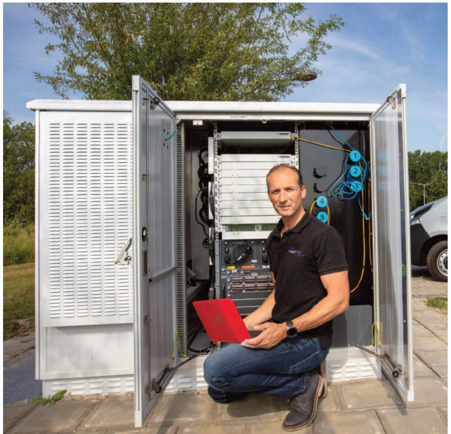
**Bild 2** | Die Schaltschränke von Tecnomit sind ausgestattet mit Stromanschluss, Verkabelung, Kühlung und/oder Heizung, USV, Batterien, Managementsystemen sowie Überspannungsschutz.
