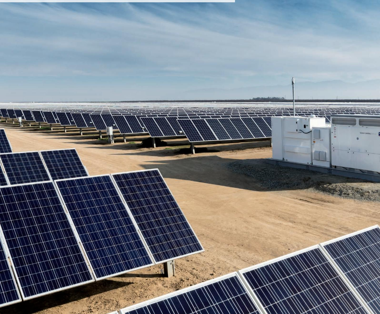
Bild 1 | In diesem 280 MW-Solkraftwerk in Kalifornien sind 127 SMA-Zentral-Wechselrichter Sunny Central 2200-US im Einsatz.
