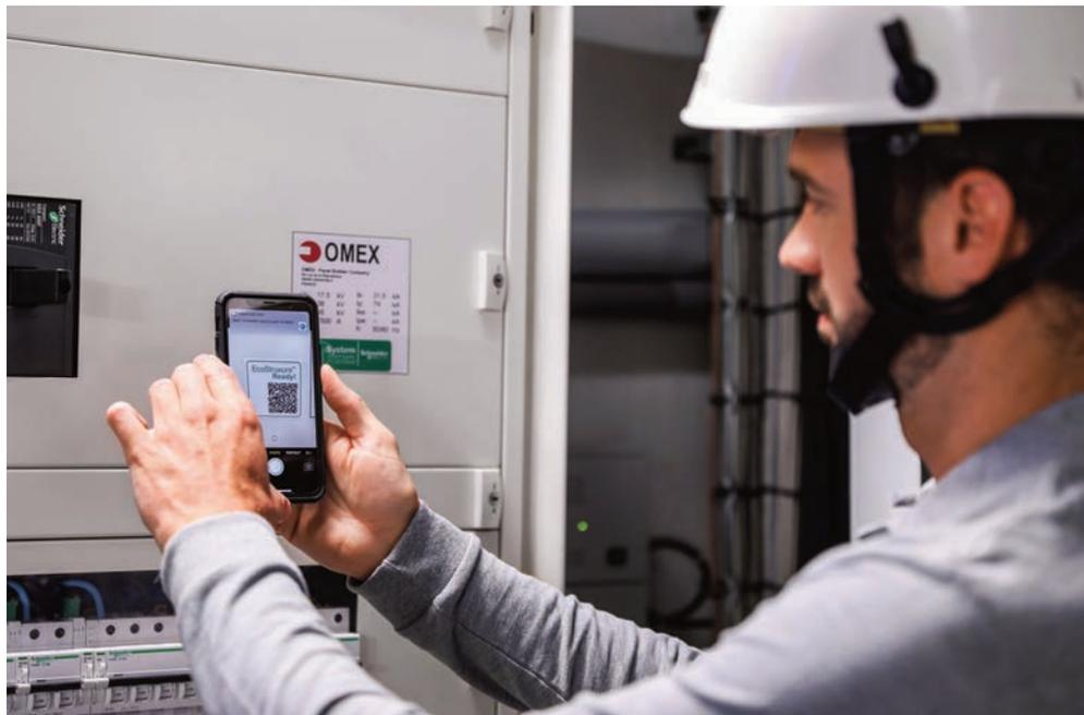
**Bild 3** | Anhand eines individuellen auf die Schaltanlage geklebten QR-Codes ist durch einfaches Scannen jederzeit der Zugriff auf die gesamte Dokumentation der Anlage möglich.
