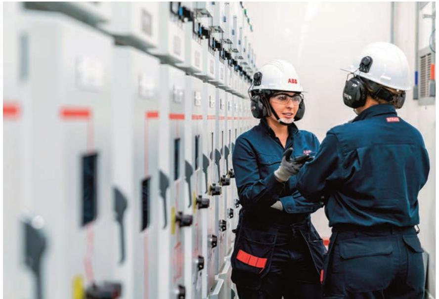
**Bild 2 |** Die Überwachung von MS-Schaltanlagen wie den hier gezeigten erfolgt mithilfe von Ethernet-basierten Kommunikationsverbindungen.
