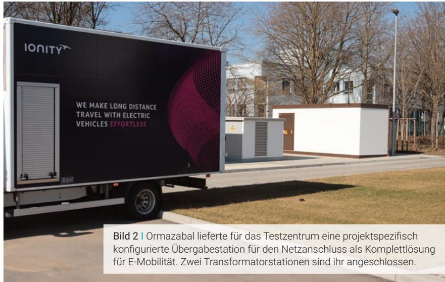
Bild 2 | Ormazabal lieferte für das Testzentrum eine projektspezifisch konfigurierte Übergabestation für den Netzanschluss als Komplettlösung für E-Mobilität. Zwei Transformatorstationen sind ihr angeschlossen.
