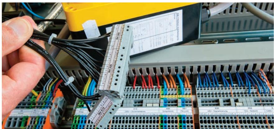
Bild 3 | Für Janzhoff-Aufzüge stellt das Wago-Angebot aus Reihenklemmen und Beschriftungssystem die geeignete Kombination dar.
