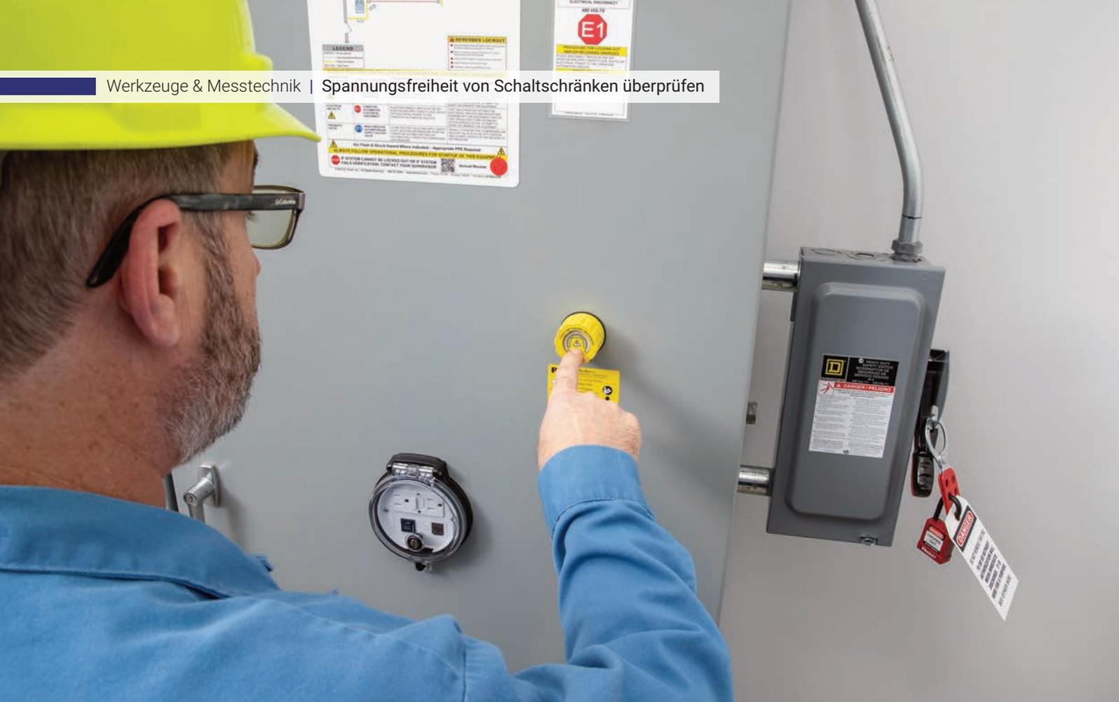
**Bild 1** | Mit einem Knopfdruck erreicht der Anwender geprüfte Sicherheit sowohl bei 3- als auch bei 1-phasigen Anwendungen im jetzt erweiterten Spannungsbereich bis zu 1000V für Wechsel- und Gleichstrom-Anwendungen.
