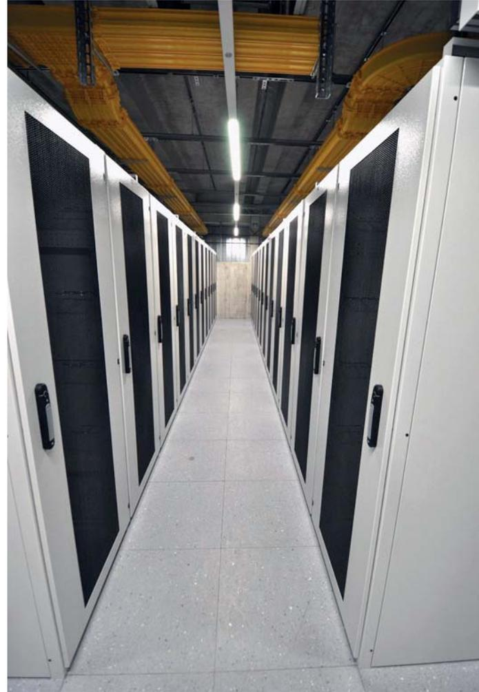
Bild 3 | Die Server im Rechenzentrum Ostschweiz sind rechnerisch zu mindestens 99,998 Prozent der Zeit verfügbar – dank fünffacher Strom- und dreifacher Glasfaseranbindung sowie Notstromversorgung.
