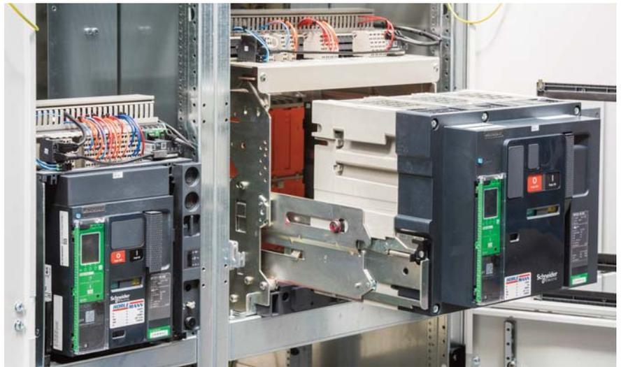
Bild 3 | Mit den Masterpact MTZ von Schneider Electric kommen offene Leistungsschalter der neuesten Generation zum Einsatz.
