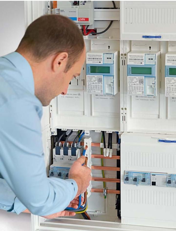
Bild 6 | Beim Hager Einspeiseadapter ESA werden die Stromleitungen einfach in Push-in-Klemmen gesteckt. Dadurch reduziert sich die Montagezeit um rund 50 Prozent.
