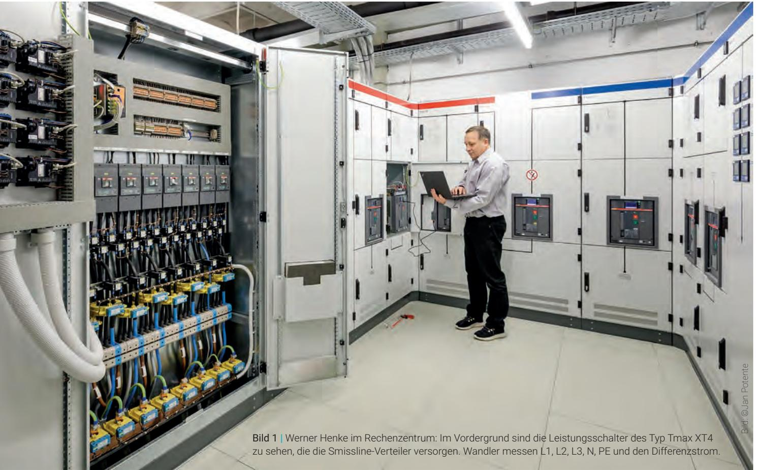
Bild 1 | Werner Henke im Rechenzentrum: Im Vordergrund sind die Leistungsschalter des Typ Tmax XT4 zu sehen, die die Smissline-Verteiler versorgen. Wandler messen L1, L2, L3, N, PE und den Differenzstrom.
