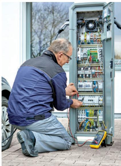
**Bild 2 | DC-Applikationsbeispiel E-Mobilität:** Ladestationen enthalten eine Vielzahl von empfindlichen elektronischen Komponenten - für eine hohe Verfügbarkeit müssen sie gegen transiente Überspannungen und Blitzeinwirkungen geschützt werden.
