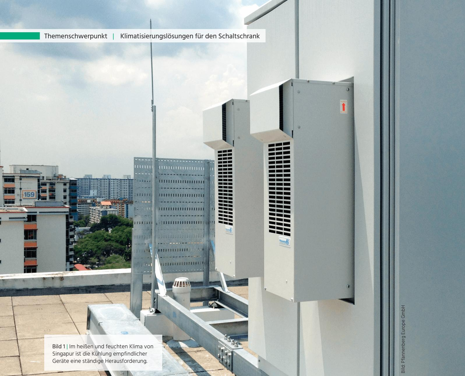
Bild 1 | Im heißen und feuchten Klima von Singapur ist die Kühlung empfindlicher Geräte eine ständige Herausforderung.
