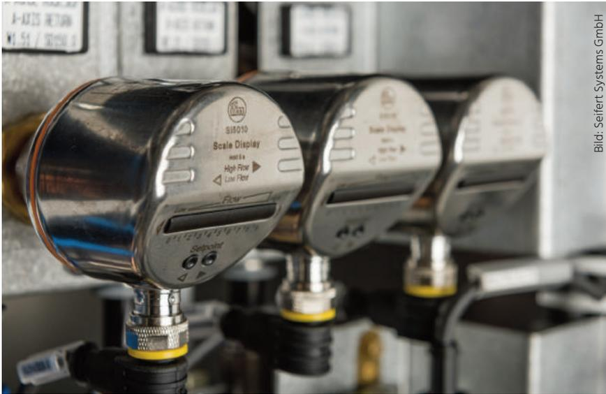
Bild 3 | Zur Überwachung und Anpassung des Wasserdurchflusses werden Rückkühlsysteme mit Durchflusssensoren und Durchflussreglern ausgestattet.
