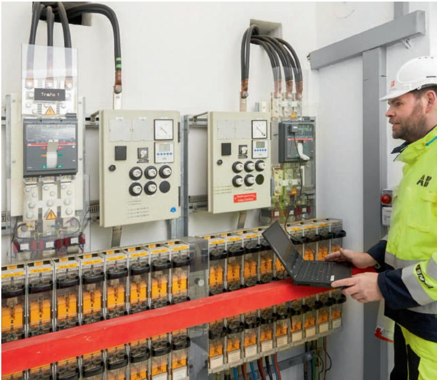
Bild 2 | Der ABB-Servicepartner kann die Daten des Schalters bei der Inbetriebnahme, aber auch für die weitere Dokumentation bequem über den Laptop auslesen.
