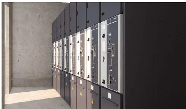
**70** Anreihbare gasisolierte 24-kV-Schaltfelder
