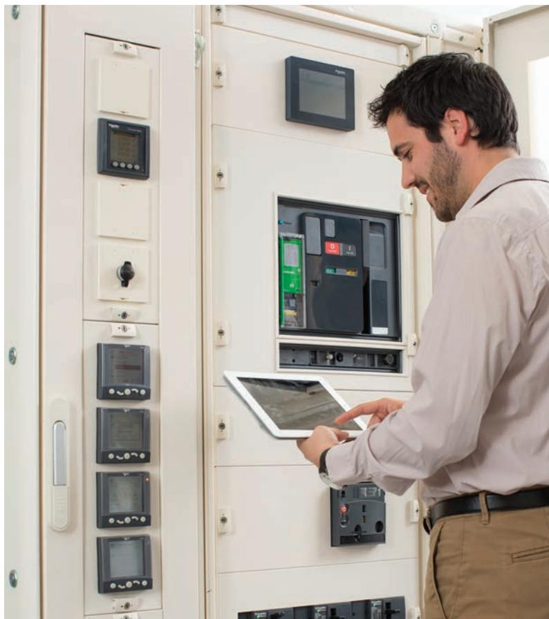
**Bild 3** | Auch die Parametrierung von Anlagenkomponenten bzw. das Auslesen des Anlagenzustands kann digital, z.B. mit Hilfe eines Tablets, erfolgen.
