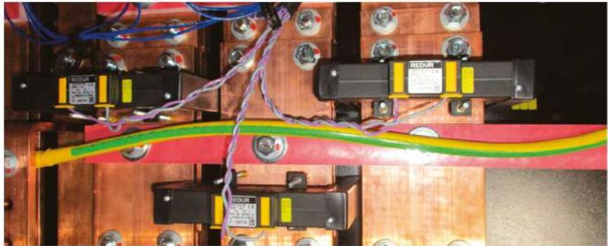
**Bild 3 |** Mit Hilfe der Fremdfeldprotektoren können Abstände zwischen Stromwandler und benachbarter Schiene minimal 30mm betragen, ohne dass die Messgenauigkeit unterschritten wird. Der Fremdfeldeinfluss kann um mehr als den Faktor 10 verringert werden.
