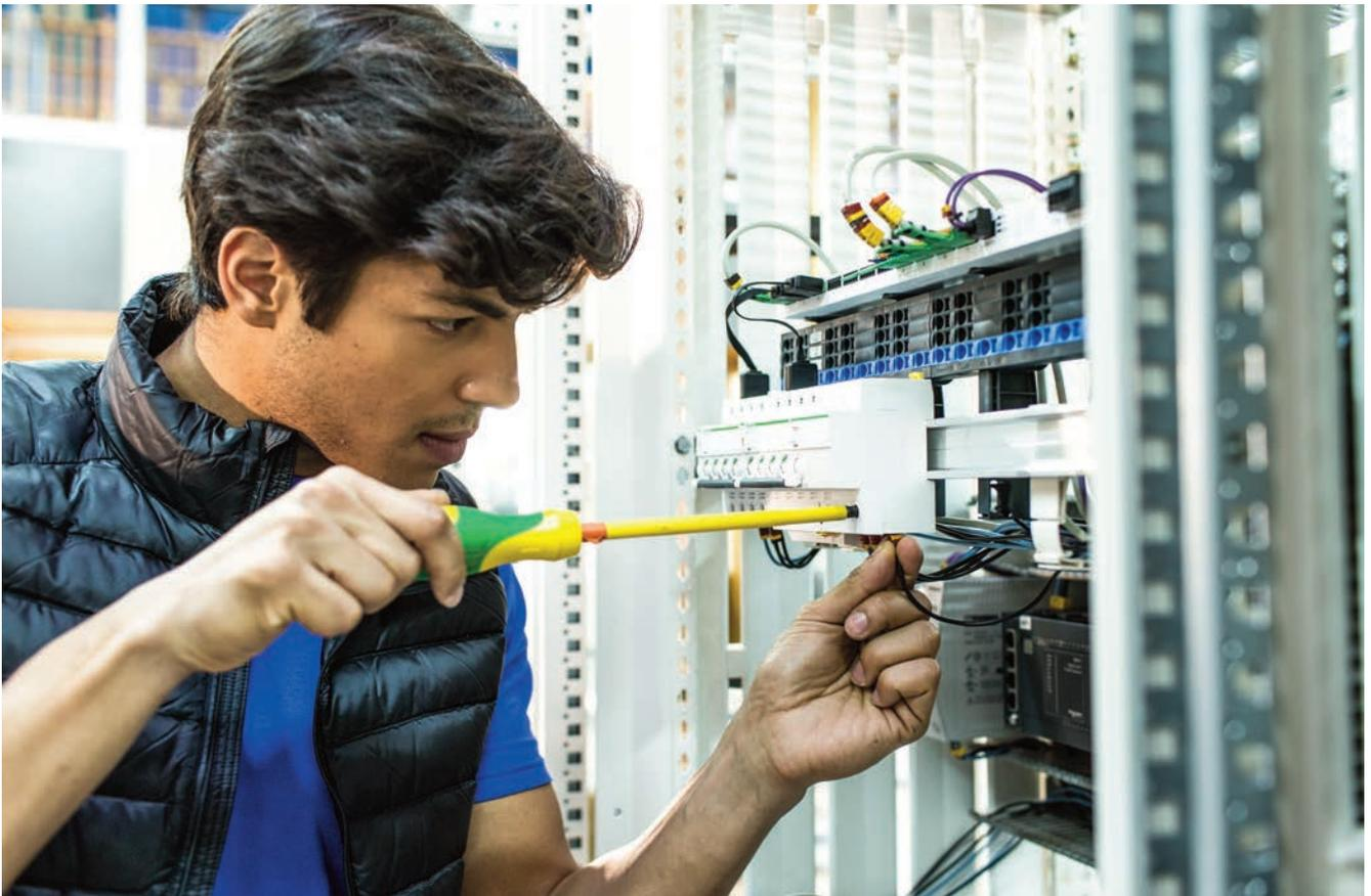
**Bild 2 |** Statt auf gedruckte Stromlaufpläne zurückgreifen zu müssen, kann die Verdrahtung komplett auf Grundlage des virtuellen 3D-Modells und der dort hinterlegten digitalen Stromlauf- und Verdrahtungspläne vorgenommen werden.
