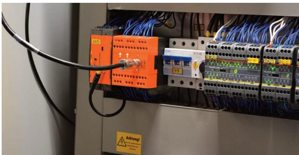
**Bild 3** | Die Sicherheits-Funkmodule von Dold sind im Schaltschrank in der unteren Etage bei der Strangpressanlage untergebracht.
