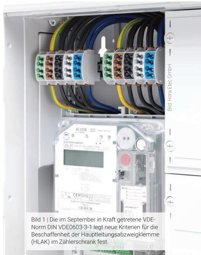
Bild 1 | Die im September in Kraft getretene VDE-Norm DIN VDE0603-3-1 legt neue Kriterien für die Beschaffenheit der Hauptleitungsabzweigklemme (HLAK) im Zählerschrank fest.
