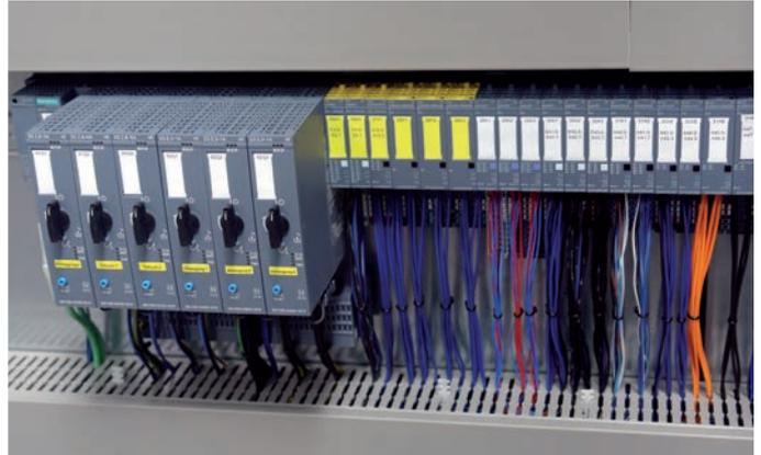
**Bild 4** | Die Motorstarter Simatic ET 200SP sind mit 30mm Baubreite sehr kompakt und integrieren neben den Schutzeinrichtungen für Überlast und Kurzschluss standardmäßig die Strommessung.
