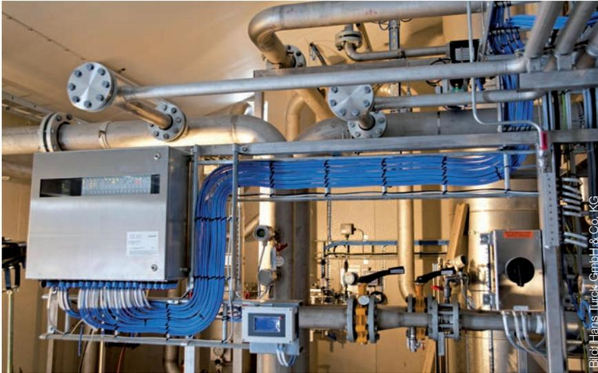
Bild 3 | Turcks Schaltschrankwächter erkennt sofort, wenn die Bedingungen im Schaltschrank oder -kasten sich ändern.
